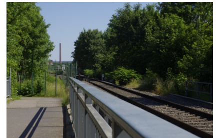
Fotos von oben nach unten Sanierungsbedarf im gründerzeitlich geprägten Teil Nachnutzungspotentiale bestehender Fußweg entlang der Bahnlinie in Richtung Stadtzentrum
