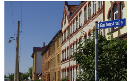
gründerzeitliche Bebauung in der Gartenstraße
