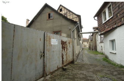
Bilder von oben nach unten Verkehrliche Belastung durch die B249 akuter Sanierungsbedarf Kugelleichsmühle und Verbindung zur Altstadt
