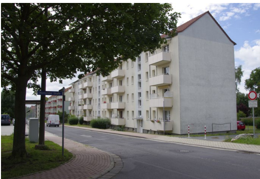
Geschosswohnungsbau im Stadtteil Forstbergviertel
