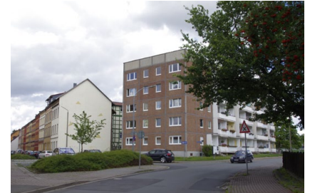
typischer Plattenbau im Gebiet Bruchstellen im Übergang zu benachbarten Stadtteilen, hier Harward
