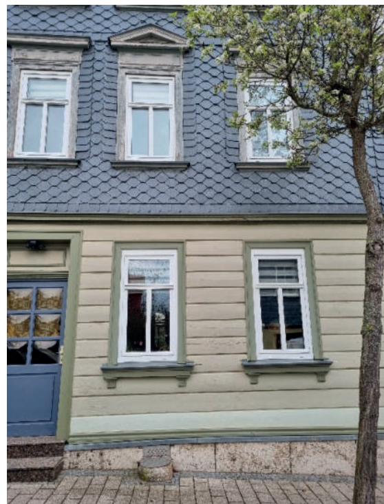
Abb. 25: historisch gegliederte und gestaltete Fenster, verschieferter Fassade im OG, Fensterbedachung, Gesims und Natursteinsockel, Grünstraße (typisch für Mühlhausen ist die vertikale Holzverschalung des EG oder als imitierte Bossen) (Quelle: Eigene Abbildung 2023)
