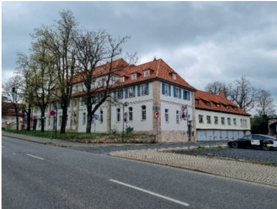
Abb. 18: Historisches Feuerwehrgebäude Bastmarkt 36 und Wahlstraße 97 (ED) (Quelle: Eigene Abbildung 2023)
