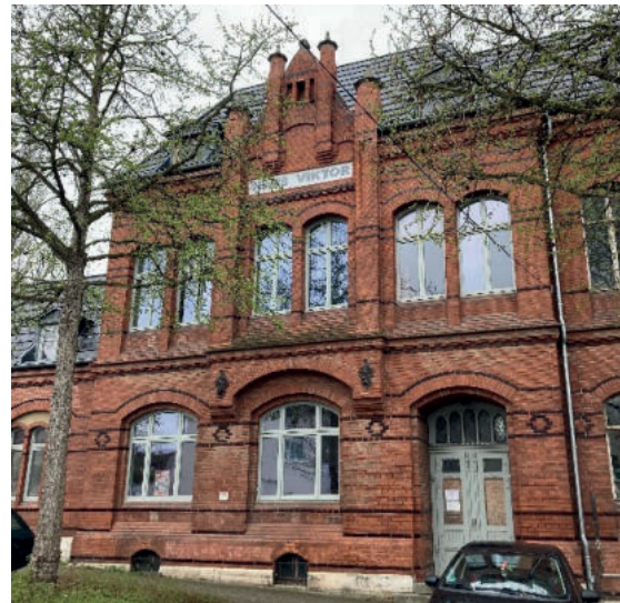
Abb. 23: Typischer Massivbau mit Klinkerfassade, um die vorletzte Jahrhundertwende, Friedensstraße 1 (Quelle: Eigene Abbildung 2023)
