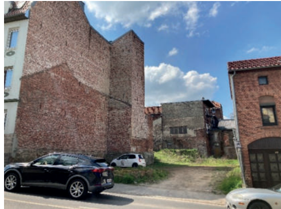
Abb. 16: Missstand durch Baulücke nach Abbruch im Petristeinweg
