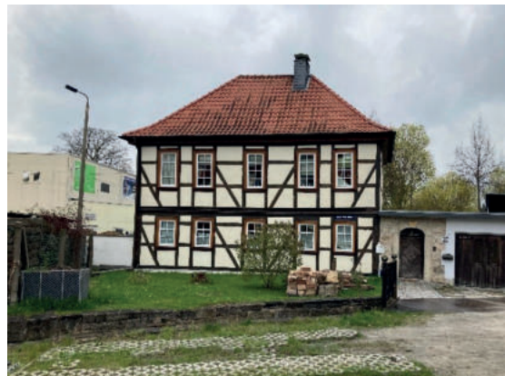
Abb. 21: typisches Sichtfachwerk, Hinterm neuen Brunnen 37 (ED) (Quelle: Eigene Abbildung 2023)
