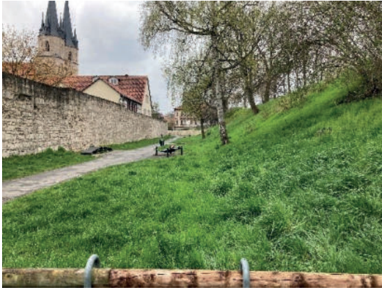
Abb. 38: westliche Wallanlage, hoher Graben (Quelle: Eigene Abbildung 2023)
