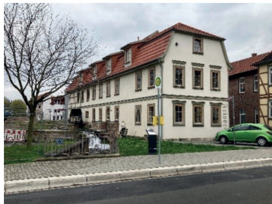
Abb. 36: Kugelmühl von Wanfrieder Straße aus gesehen (Quelle: Eigene Abbildung 2023)
