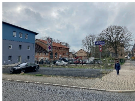
Abb. 14: fehlende hochbauliche Raumkante am Bastmarkt, Ecke Wahlstraße (Quelle: Eigene Abbildung 2023)
