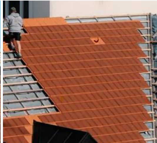
Abbildung 3-4: PV-Ziegel bei der Montage (Autarq GmbH)
